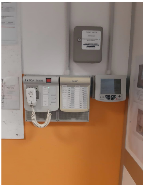
Centralina di diffusione messaggi (EVEC) Piano Terra
