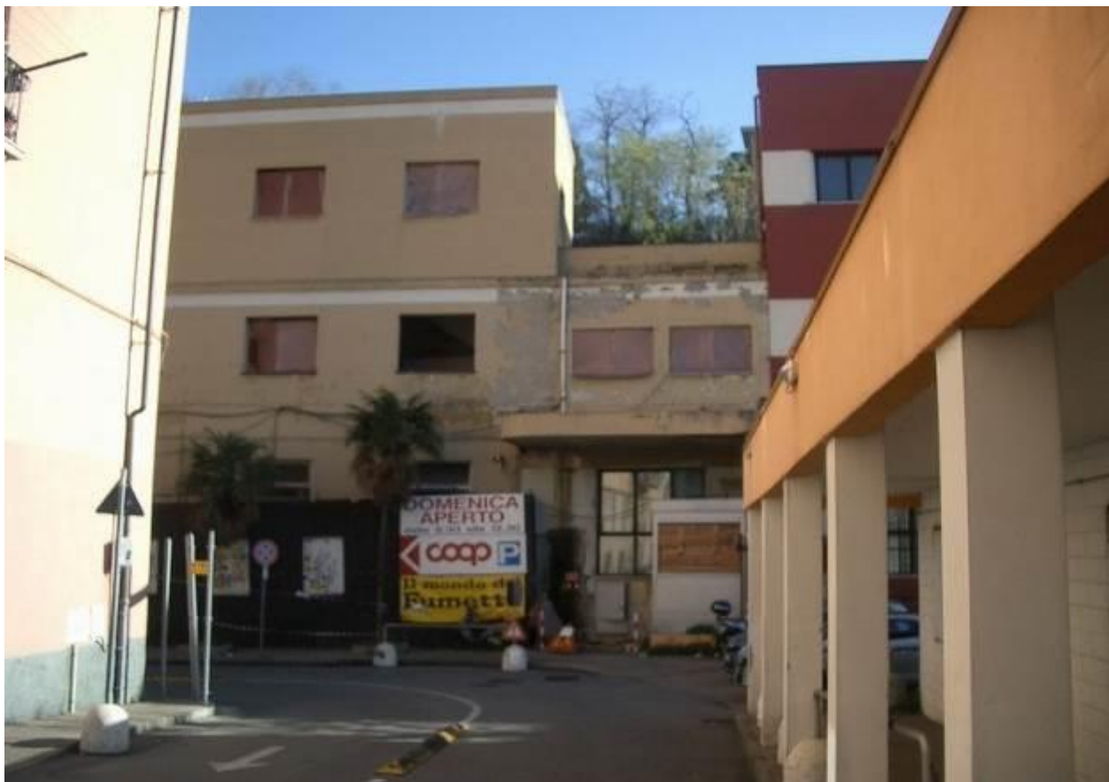
ESTERNO – VISUALE DA STRADA PRIVATA DI ACCESSO (DA C.SO GASTALDI)
