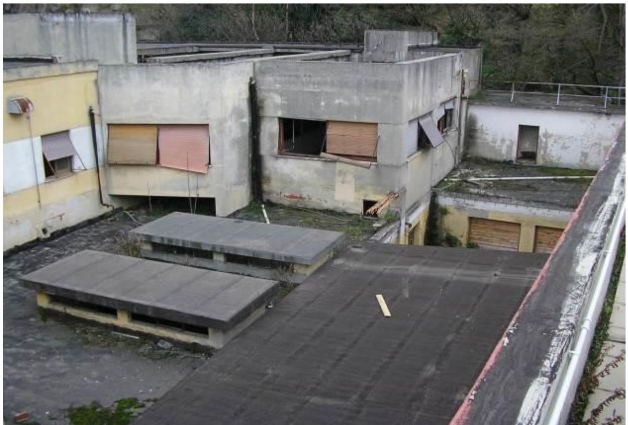
COPERTURA – VISUALE DA “LOTTO 4”
